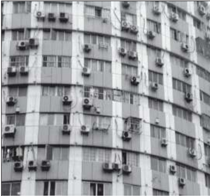
Figure 1. I sistemi Split sono sistemi d'aria condizionata a facciata con ogni condensatore montato esternamente alla stanza per la quale lavorano. Riferimento: Split System, 2014.
