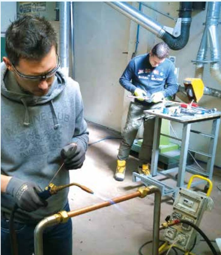
A Motta di Livenza, durante l'esame del Patentino Frigoristi, un Tecnico esegue una saldobrasatura. Soprattutto in previsione dello storico cambio di refrigeranti, che saranno leggermente infiammabili, eseguire brasature di livello sarà fondamentale per l'incolumità di tecnici e utilizzatori finali per evitare perdite di refrigerante.
