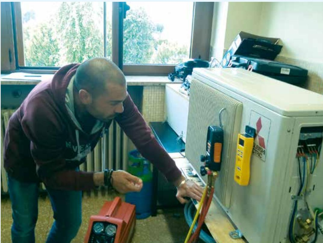
Carica Vuoto dell'impianto. Eseguire l'operazione perfettamente, senza alcuna perdita di gas, è requisito fondamentale per superare l'esame da Tecnico del Freddo. La strumentazione analogica collegabile pure agli attuali strumenti tecnologici per la condivisione è importante per poter dimostrare il corretto funzionamento dell'impianto con i corretti parametri di pressione e temperatura. Comprate solo materiali e bombole da fonti certe. Refrigeranti illegali sono stati denunciati sul mercato.
