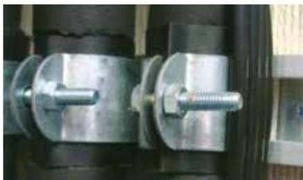
Giunti di fissaggio per tubi.
